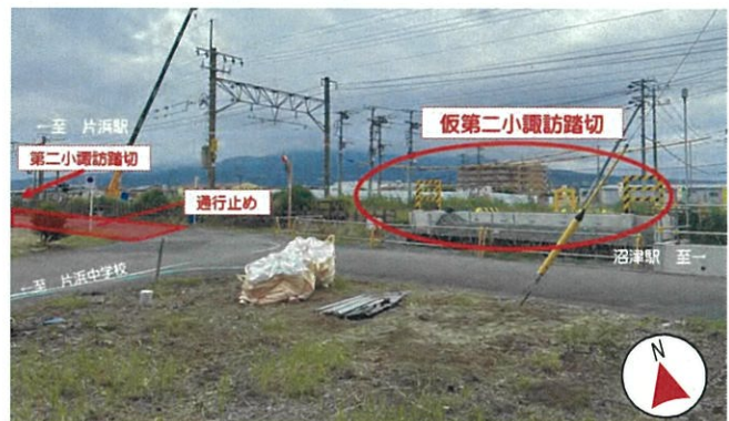
〔仮第二小諏訪踏切〕 開通
